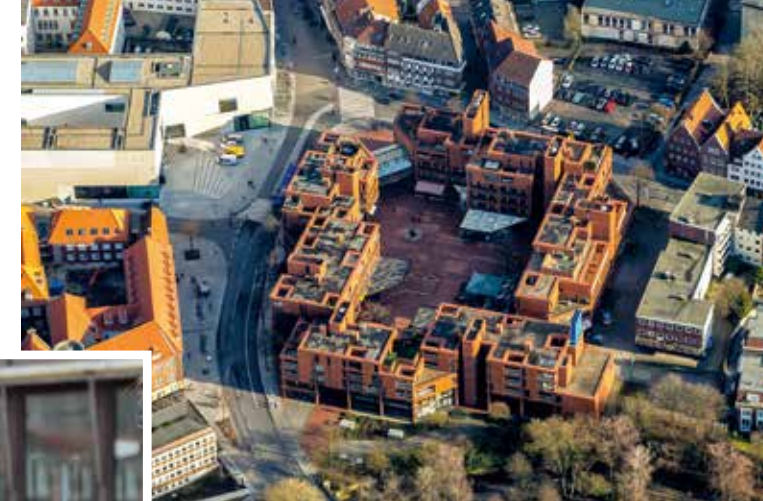
Shopping center with bunker / Einkaufszentrum mit Bunker: Aegidiimarkt
